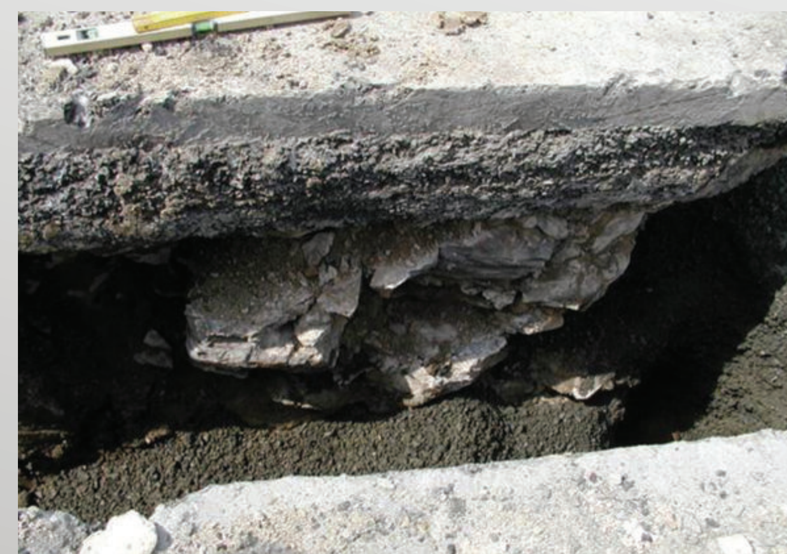
Základy Dolní brány, Švihov – Nádražní ulice
